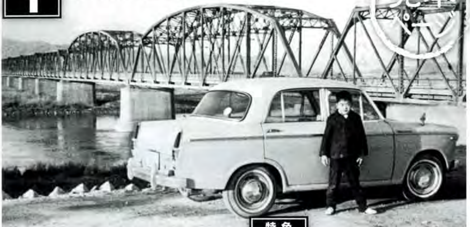
▲初代の枚方大橋 枚方市と高槻市を結ぶ初代の枚方大橋前で撮影されたスナップ写真。昭和5年完成の同橋は、京阪電鉄の宇治川と木津川の鉄橋付け替えに伴い、既存の鉄橋を譲り受けて造られた道路橋である。現在の橋は2代目で、昭和43年に架け替えられた。少年の背後に写る自動車はダットサン・ブルーバードP312型。(淀川付近・昭和41年)
